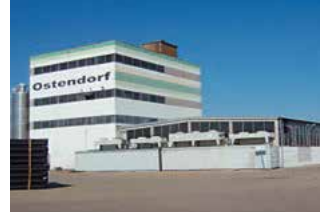
Rain am Lech Fabrikası
