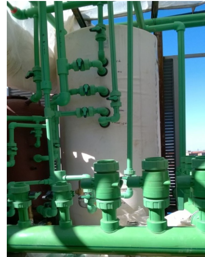
Akka İnş. Sıraselviler Hotel Uygulaması
