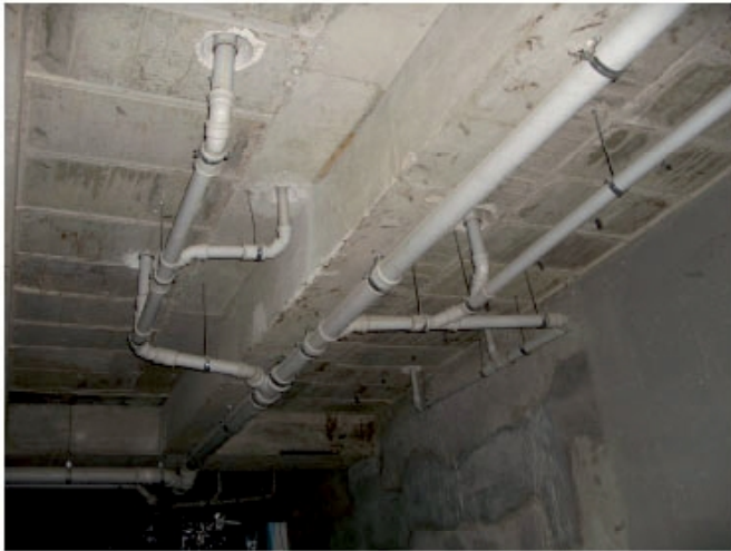
Yapı Plaza Wavin döşemesi
