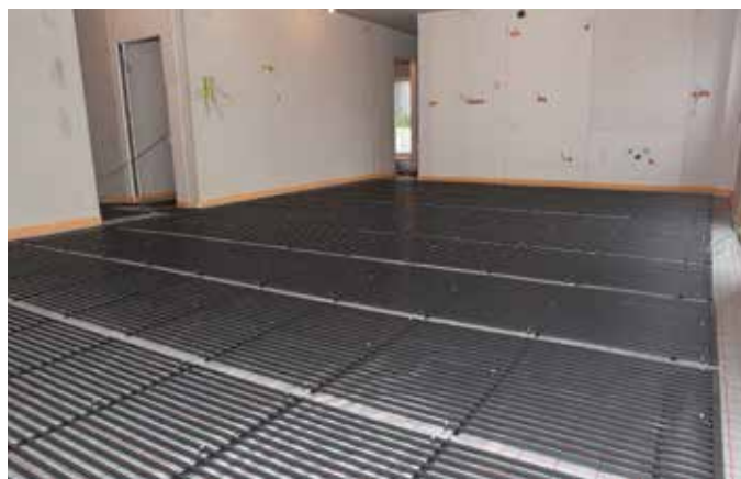
2. aquatherm black system als Flächenheizsystem auf bauseitiger Dämmung.
